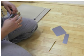
1. Coller la zone de forage
