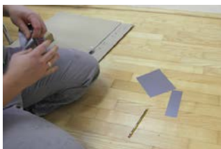
1. Abkleben der Bohrstelle
