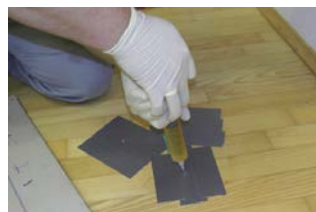
6. Einfüllen mit Nadel
